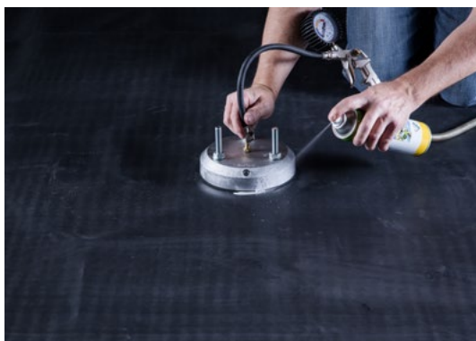
Hohlraum im Dichtteil unter Druck setzen und mit Lecksuchspray auf Luftaustritt prüfen
