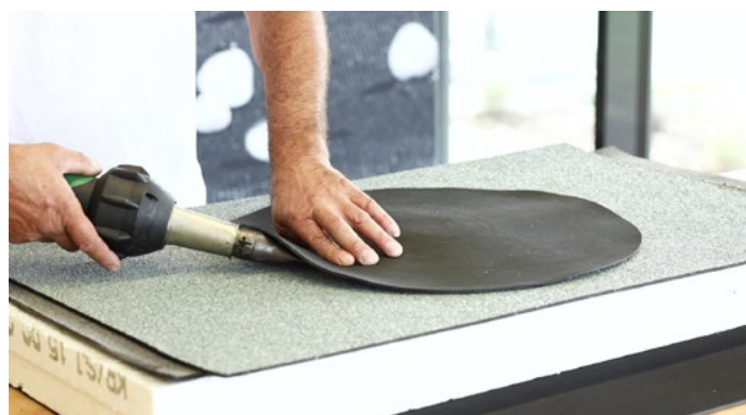
Rondelle mit Bitumen-Dachbahn verbinden*
