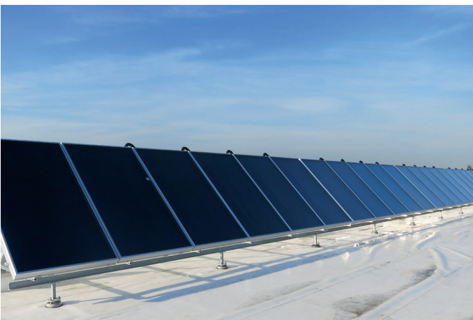
Photovoltaik- u. Solaranlagen
